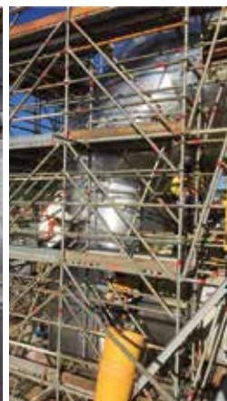
Pose de calorifuge sur tuyauterie de DN 4000
