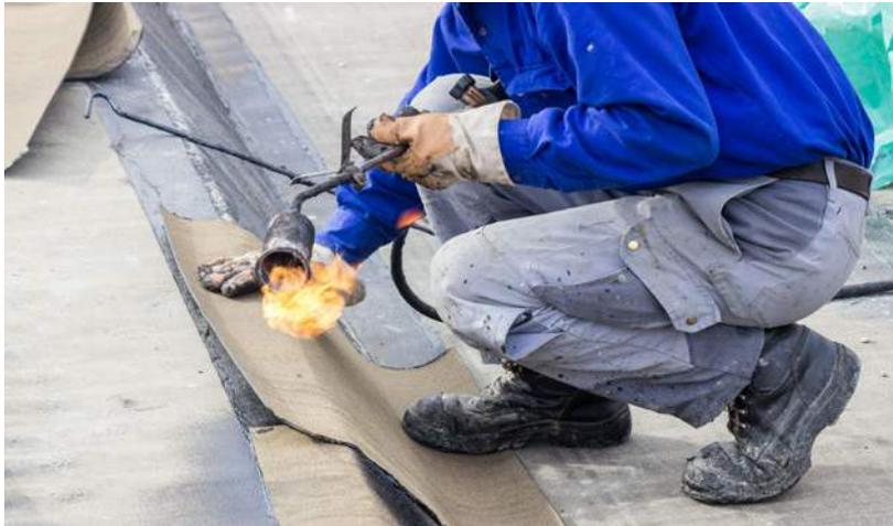
Assurer l'étanchéité dans un bâtiment consiste à éviter des infiltrations d'eau dans les murs, le sol ou le toit afin qu'ils ne viennent endommager la structure et l'isolation du bâtiment.
