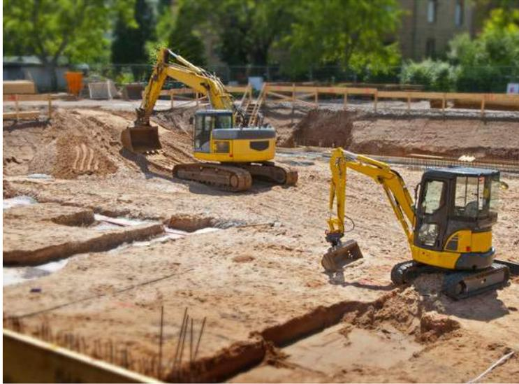
Le terrassement désigne l'ensemble des opérations de mise en forme d'un terrain liées à l'édification d'une construction. Il consiste à déplacer des grandes quantités de matériaux (sols, roches, etc.).
